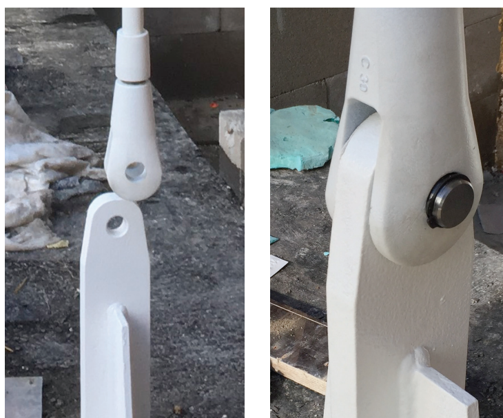
Styčnickový plech a napojení táhla.
